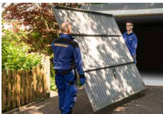
Ausbau und umweltgerechte Entsorgung
